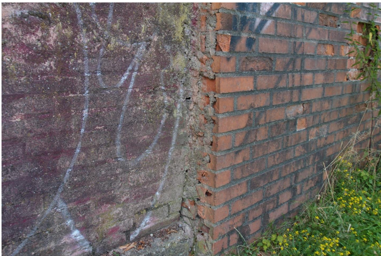
44. Staničení V5, vnější pohled, detail – technologická spára
