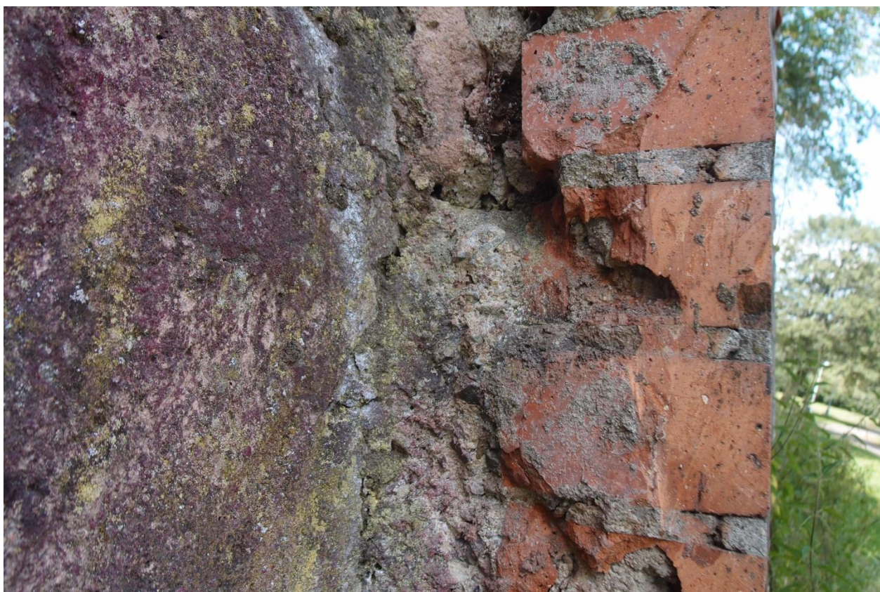
45. Staničení V5, vnější pohled, detail – technologická spára
