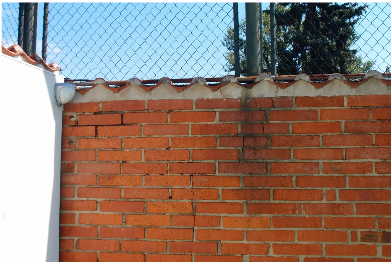
5. Kout V2, vnitřní pohled, detail – trhlina ve zdivu
