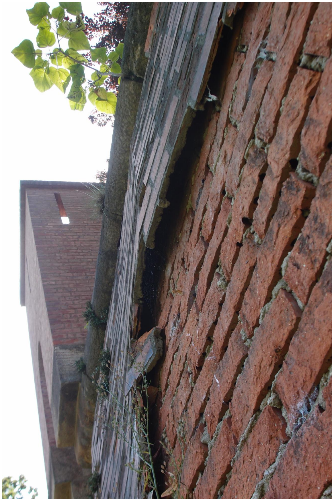
41. Úsek V4-V5, vnější pohled, detail – poškození přizdívky
