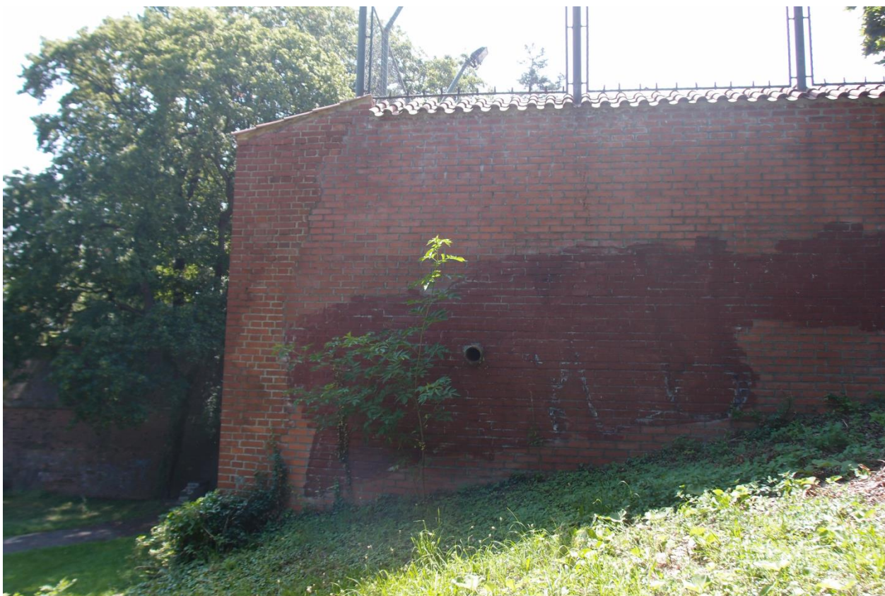
16. Nároží V2, vnější pohled, detail – technologická spára
