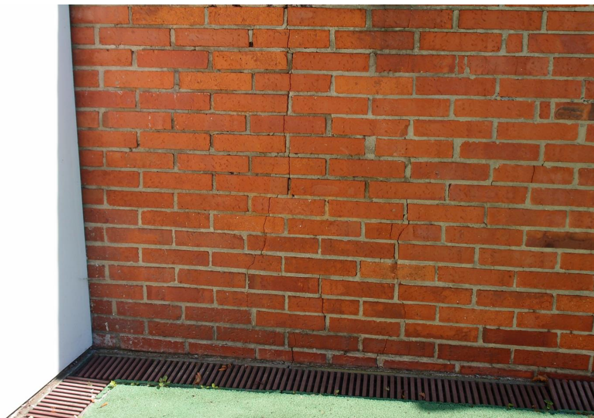
6. Kout V2, vnitřní pohled, detail – trhlina ve zdivu
