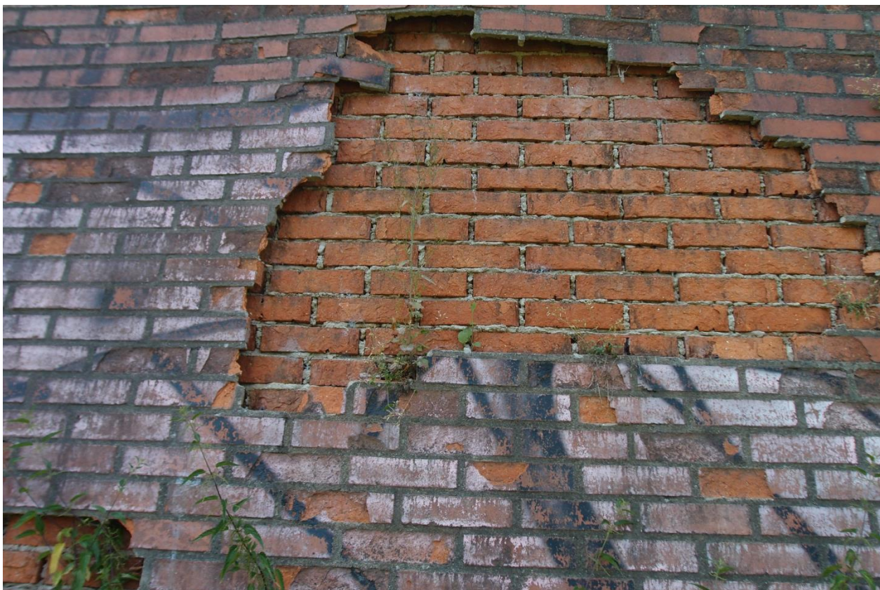
40. Úsek V4-V5, vnější pohled, detail – poškození přizdívky
